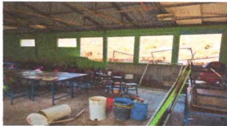
Reparación de balcones y puerta
