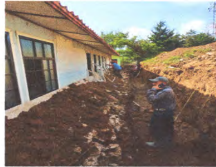
Reparación de muro de contención
