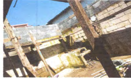
Reparación de cocinas, pilas y techo
