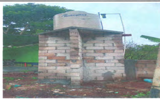
Foto4: INSTALACION DE TINACO CON BASE
