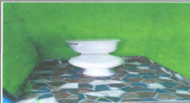
Foto3: INSTALACIONES BAÑOS NUEVOS
