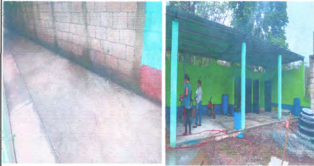
Foto1: IMPERMEABILIZACION DE LOSA Y LOSA DEL PATIO
