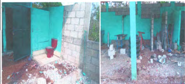
Foto1:REPARACION DE PAREDES E INSTALACION DE BAÑOS NUEVOS Y LOSA DE CONCRETO
