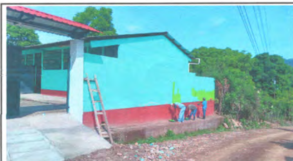
Foto: 5 PINTADO DE MURO EXTERIOR Y FUNDICION DE RAMPA DE ENTRADA DE LA ESCUELA Y REPARACION DE PORTON
