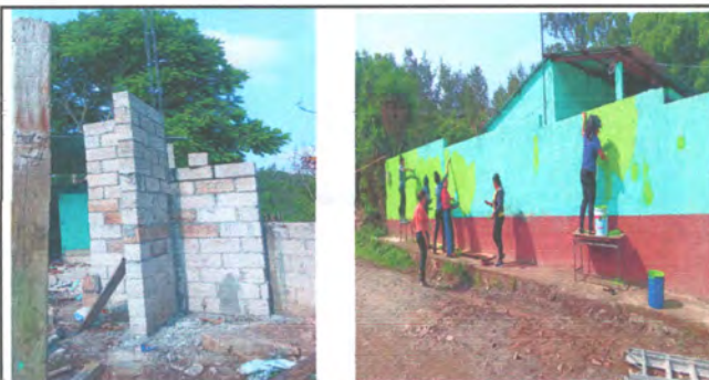
Foto3: CONSTRUCCION DE BASE DE TINACO Y PINTADO DE MURO EXTERIOR
