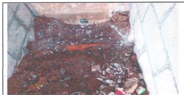
Foto: INSTALACION DE DRENAJES Y TUBERIA DE ENTRADA DE AGUA
