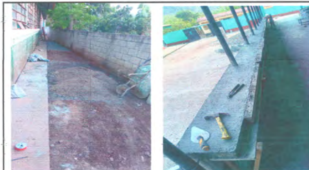
FOTO 2: INSTALACION DE LOSA DE CONCRETO Y FUNDICION DE PASAMANO CON REPARACION DE BARANDAL
