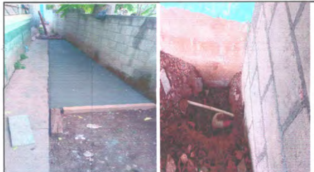
Foto4: INSTALACION DE LOSA DE CONCRETO EN LA PARTE TRASERA DE LA ESCUELA Y TUBERIA DE DRENAJES DE BAÑOS
