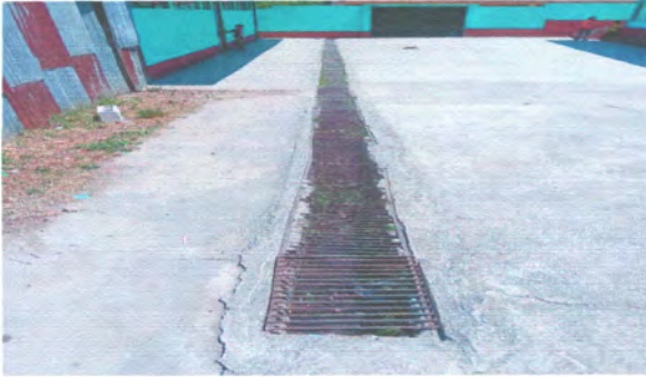
Foto1: IMPERMEABILIZACION DE LOSA DE PATIO
