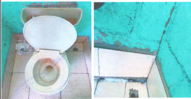
Foto3: TAZAS NUEVAS Y LEVANTAMIENTO DE PAREDES
