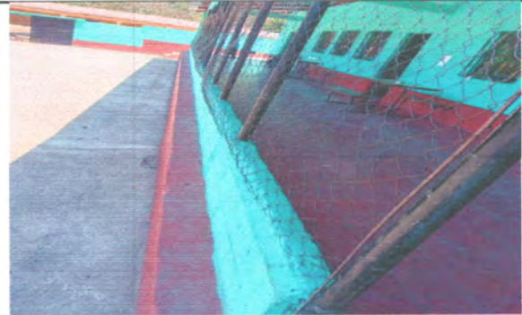
Foto4: REPARACION DE BARANDA REFORZADAS CON FUNDICION DE CONCRETO
