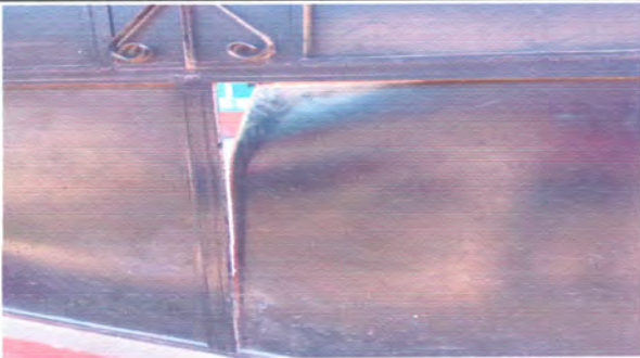
Foto: 5 REPARACION DE LAMINA DEL PORTON Y MURO DE CONCRETO DONDE SE SOSTIENE
