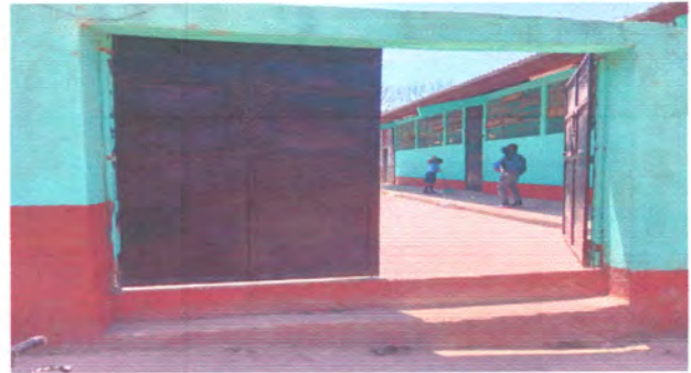
FOTO 2: PINTURA EN MUROS EXTERIOR
