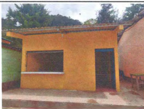
Foto: 5 Sustitución de 64 metros de pintura en muros de interior y exterior de cocina
