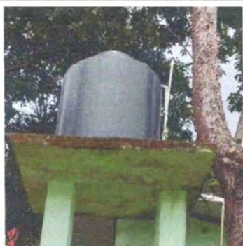
Foto 9: Mantenimiento de depósito de agua
