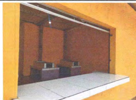
Foto: 6 Sustitución de azulejo en 2 estufas rurales y en desayunoador
