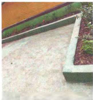
Foto 7: Sustrucción de 36 metros de losa de patio
