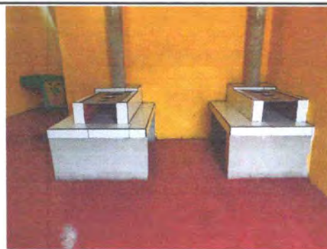
Foto 4: Sustitución de torta de cemento con color
