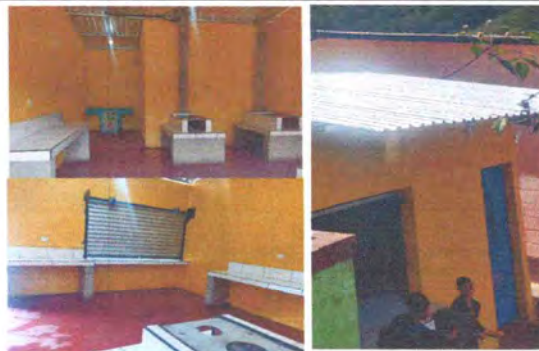
Foto 10: Sustrucción de área de cocina (2 estufas rurales, 2 chimeneas, 1 pila, 2 mesas de cemento y 1 desayunador)
