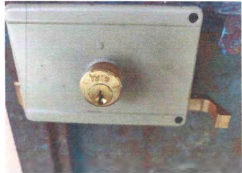
FOTO 2: Sustitución de 7 chapas de puerta y sustitución de 2 puertas
