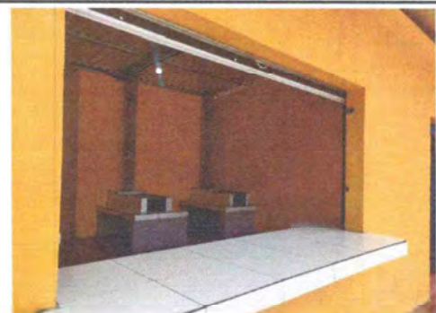
Foto: 6 Sustitución de azulejo en 2 estufas rurales y en desayunoador
