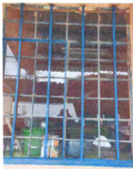
Foto 3: Sustitución de 2 ventanas
