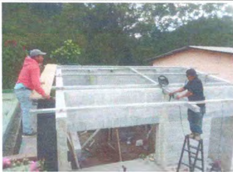
Foto1: Sustitución de 32 metros de lámina troquelada calibre 26 y costaneras
