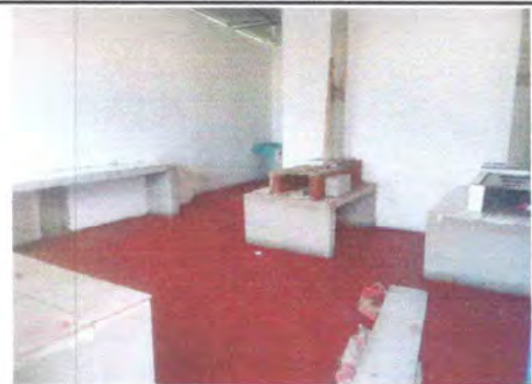
Foto 4: Sustitución de torta de cemento con color
