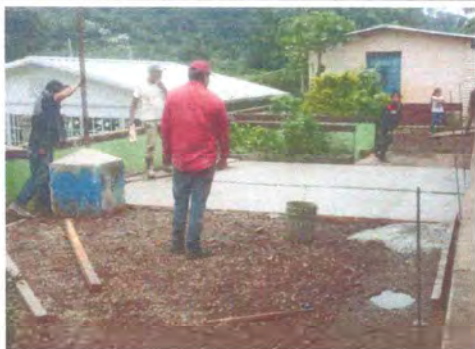
Foto 7: Sustitución de 36 metros de losa de patio
