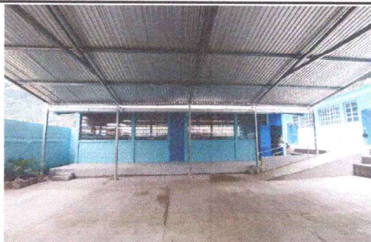
Foto1: SUSTITUCIÓN LOSA DE PATIO INCLUYE BASE, DEMOLICIÓN, FUNDICIÓN Y ACABADOS
