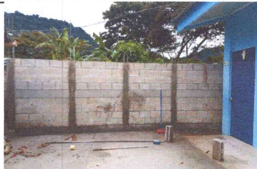
Foto 2: SUSTITUCION MURO DE BLOCK PINEADO INCLUYE TUBOS DE DRENADO
