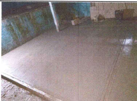
Foto 1: SUSTITUCIÓN LOSA DE PATIO INCLUYE BASE, FUNDICIÓN, DEMOLICIÓN Y ACABADO
