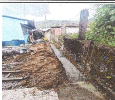
Foto 2: SUSTITUCIÓN MURO DE BLOCK PINEADO INCLUYE TUBOS DE DRENADO
