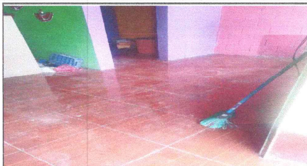
foto 2: finalización de colocacion de piso ceramico.
