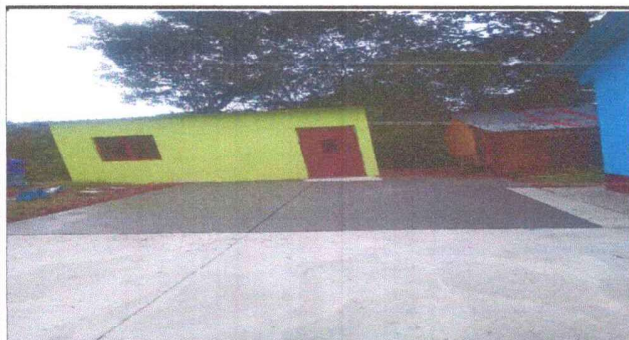
Foto 3: Ternimación de losa .
