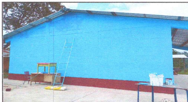
Foto 4: terminación de pintura en paredes del aula.
