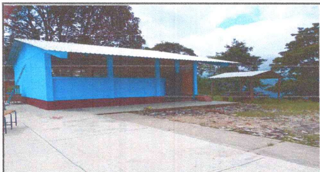
Foto1: finalización de colocación de techo en aula.
