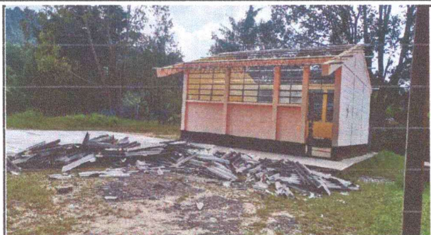
Foto1: eliminación de techo de aula en mal estado.
