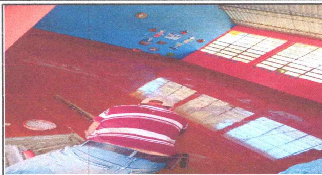
Foto 2: sustitución de piso que se encuentra en mal estado.
