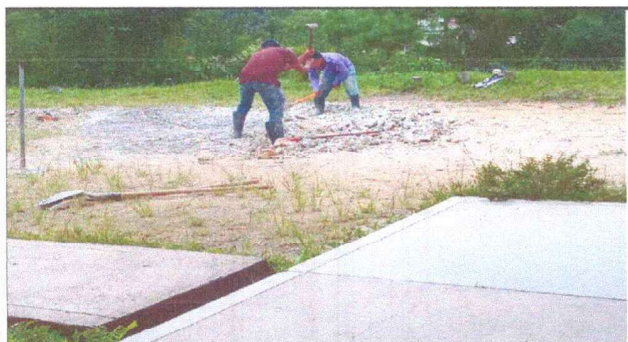
Foto 3: anulación de losa que se encontraba en mal estado.
