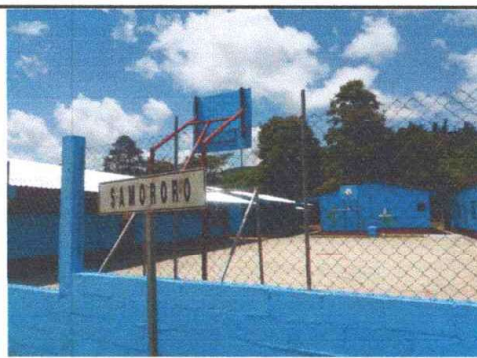
Foto 4: pintura interior y exterior
