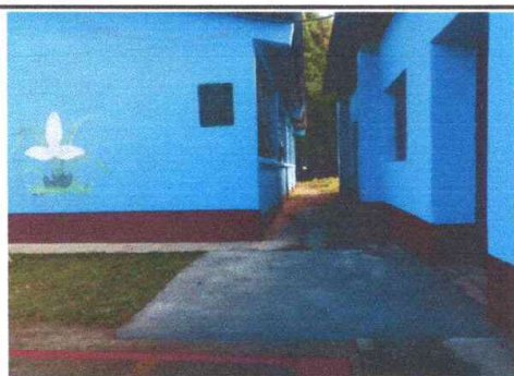
Foto 5: Losa de patio
