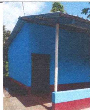
FOTO 2: Cambio de estructura de techo en cocina
