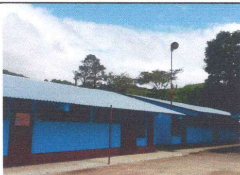
Foto 1: cambio de techo en aulas
