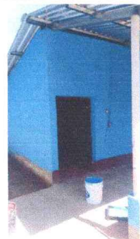
Foto 4: pintura interior y exterior
