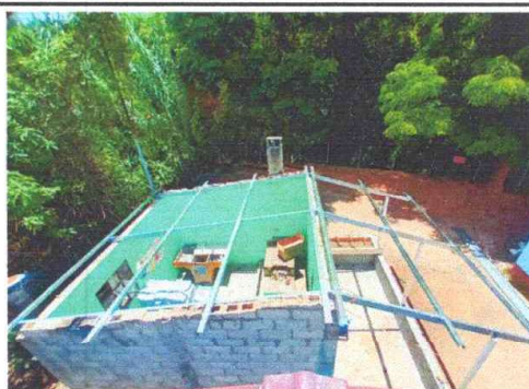
FOTO 2: Cambio de estructura de techo en cocina
