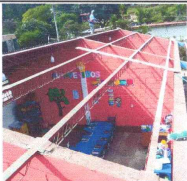
Foto 1: cambio de techo en aulas
