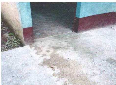
Foto 3: Piso en cocina
