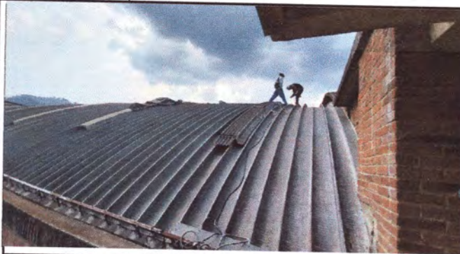
Foto1: SUSTITUCION DE CUBIERTA DE LAMINA TRAGALUZ DEL TECHO DEL AUDITORIUM DE LA ESCUELA
