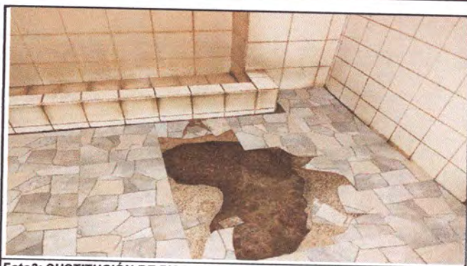
Foto3: SUSTITUCIÓN DE PISO MODULO DE SANITARIOS DE NIÑOS, DE NIÑAS, VESTIDORES Y PASILLO DE PILAS.
