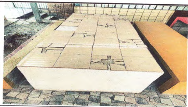
Foto: 5 SUSTITUCIÓN DE AZULEJO A MESAS DEL AREA DE COMEDOR Y COCINA.
