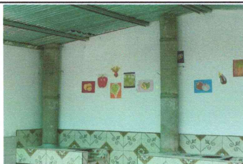
Foto 6: Sustrucción de chimeneas
