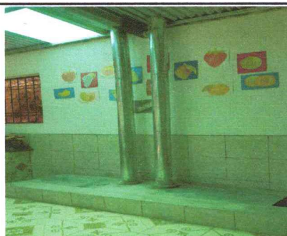
Foto 5: Sustrucción de planchas
