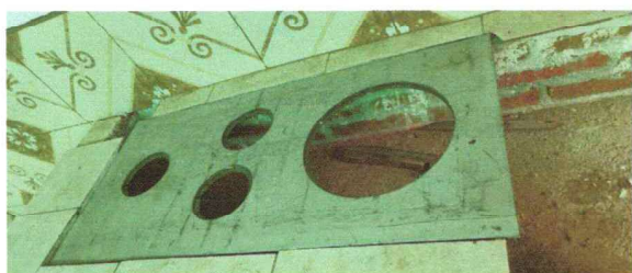
Foto 5: Sustitución de chimeneas
