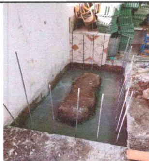
Foto 6: Susitución de pila
