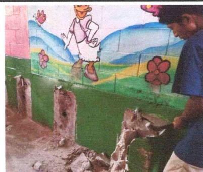
Foto 3: sustitución de lavamanos con filtraciones
