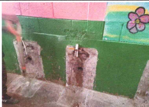
Foto 4: sustitución de tubería de lavamanos en mal estado
