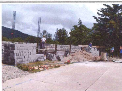
Foto 2 sustitucion de muro perimetral en riesgo
