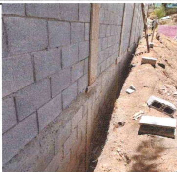
Foto1: sustitución de muro perimetral en mal estado
