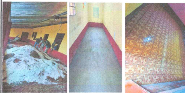
Foto1: SUSTITUCION DE PISO
