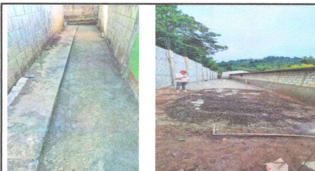
Foto 3: LOSA DE PATIO
