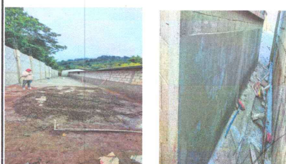
Foto 2: REPARACION DE CERNIDO Y REPELLO EN PAREDES
