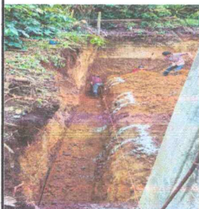
Foto 5: SUSTITUCION DE MURO DE CONTENCIÓN
