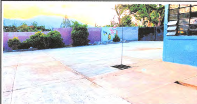
Foto1: Reparacion de losa de patio
