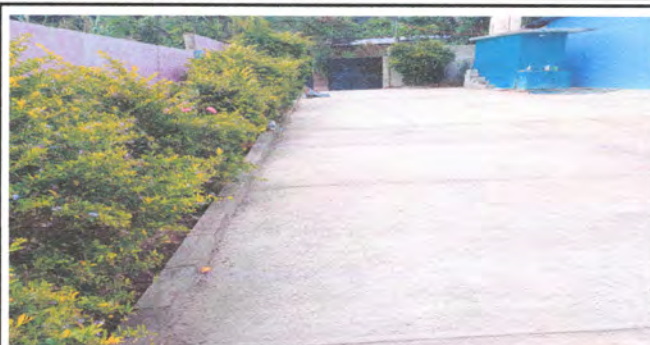
FOTO 2: Reparacion de losa de patio
