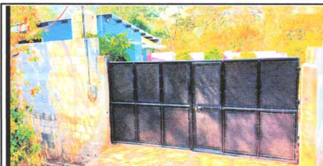
Foto: 5 Reparacion de portones
