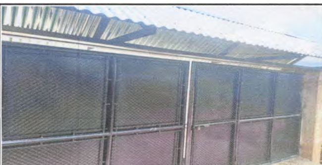
Foto: 6 Reparacion de portones
