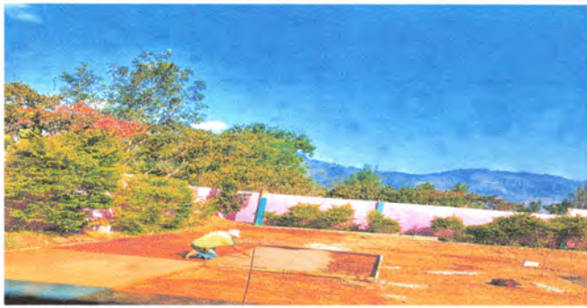
Foto1: Reparacion de losa en mal estado
