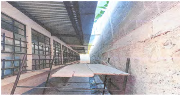
Foto3: Reparacion de Canales y bajadas de agua pluvial
