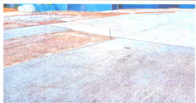
FOTO 2: Reparacion de losa en mal estado
