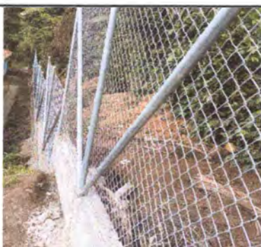
Foto 9: Reposición de muro perimetral
