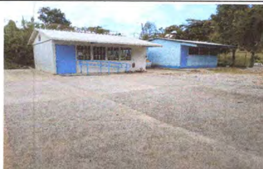
Foto 10: Reposición de losa de patio
