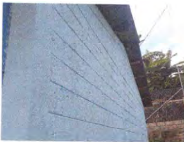
Foto 5: Pintura en paredes
