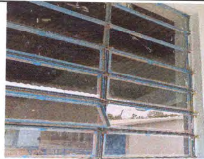
Foto 2: Limpieza general de ventanales
