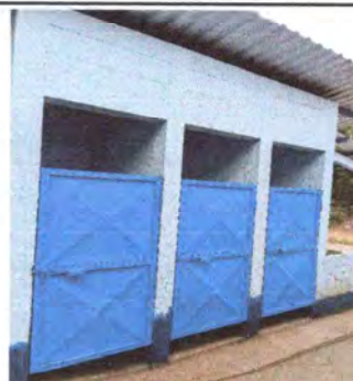
Foto 8: Limpieza y habilitación de sanitarios
