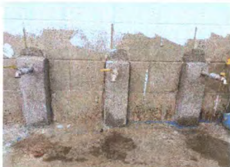
Foto 7: Reparación de Tubería de agua entubada para módulo de baños
