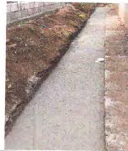
Foto 4: Reparación y Reposición de cuneta
