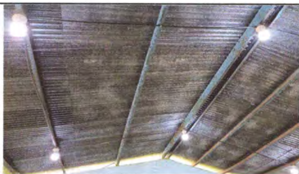
Foto 11: Reparación de sistema eléctrico
