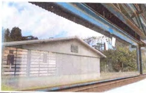
Foto 3: Reemplazo de ventanas dañadas
