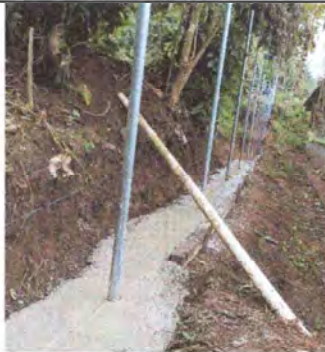
Foto 9: Reposición de muro perimetral
