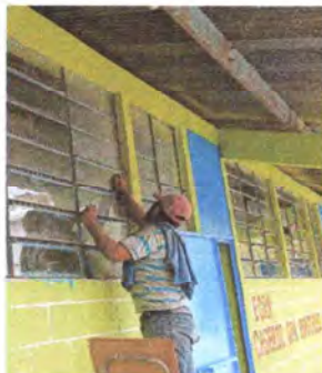
Foto 3: Reemplazo de ventanas dañadas
