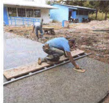
Foto 10: Reposición de losa de patio
