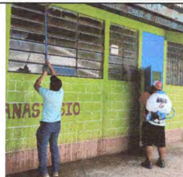
Foto 2: Limpieza general de ventanales
