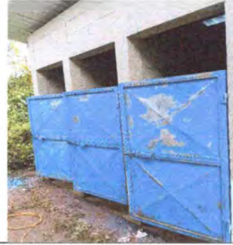
Foto 8: Limpieza y habilitación de sanitarios
