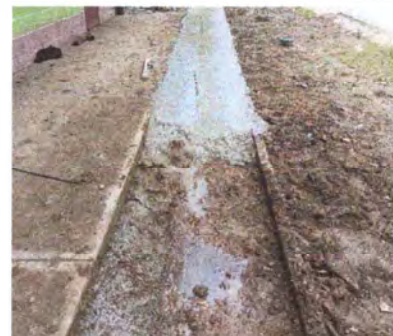
Foto 4: Reparación y Reposición de cuneta
