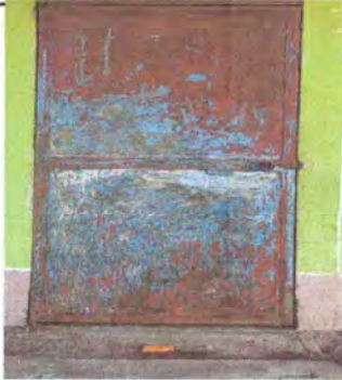
Foto 1: Limpieza y pintura de puertas
