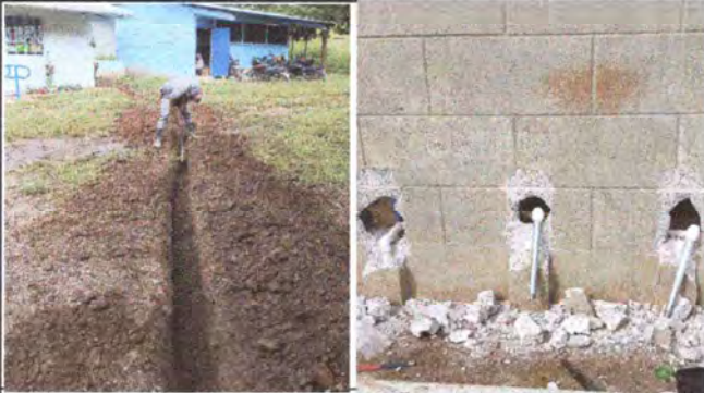
Foto 7: Reparación de Tubería de agua enterrada para moquillo de banos
