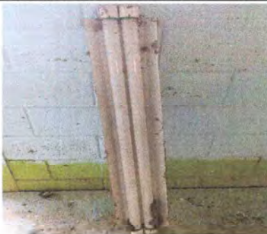
Foto 11: Reparación de sistema eléctrico
