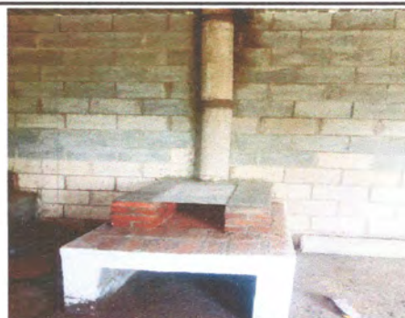
Foto4: SUSTITUCION DE ORNILLAS
