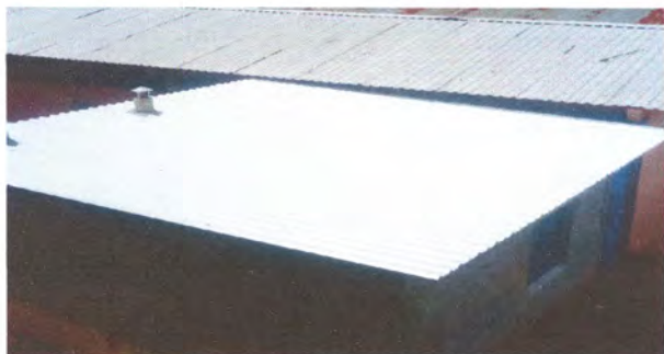
Foto1: SUSTITUCION DE CUBIERTA DE LAMINA
