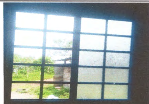
Foto3: SUSTITUCIÓN DE VENTANA
