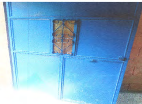
FOTO 2: SUSTITUCIÓN DE PUERTAS
