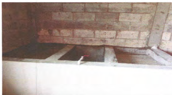
Foto: 6 SUSTITUCIÓN DE PILAS
