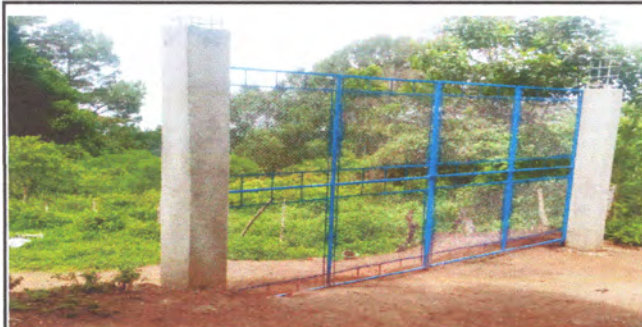
Foto: 5 MANTENIMIENTO A PORTONES
