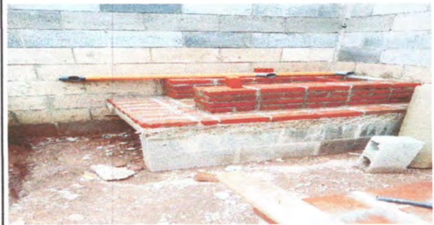
Foto4: SUSTITUCIÓN DE ORNILLA
