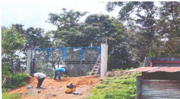
Foto: 5 MANTENIMIENTO A PORTONES
