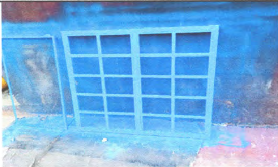
Foto3: SUSTITUCIÓN DE VENTANA
