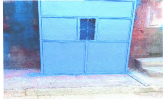
FOTO 2: SUSTITUCION DE PUERTAS
