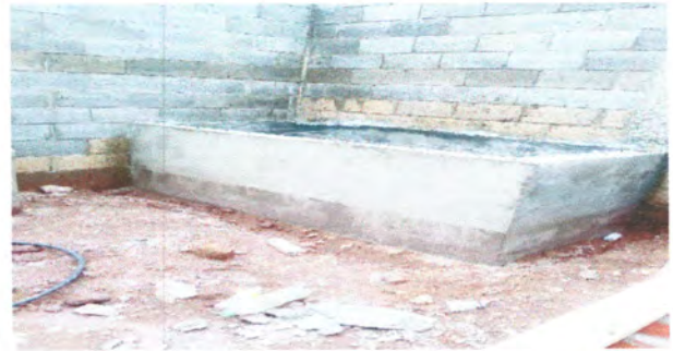
Foto: 6 SUSTITUCIÓN DE TANQUE DE AGUA
