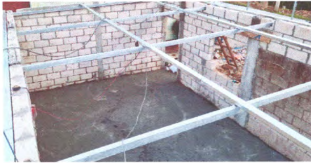
Foto1: SUSTITUCION DE CUBIERTA DE LAMINA
