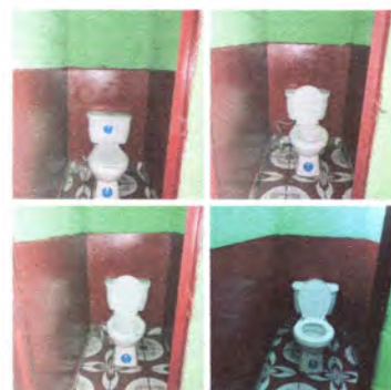
Foto4: Sustitución de sanitarios completos.
