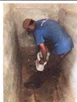
Foto4: Sustitución de sanitarios completos.
