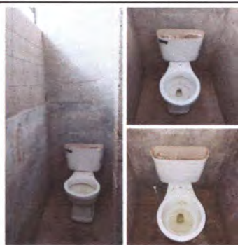
Foto4: Sustitución de sanitarios completos.
