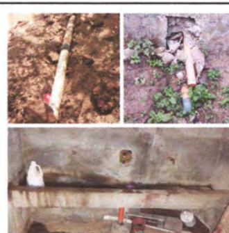
Foto: 6 Reparación de drenajes del área de los sanitarios y la cocina.
