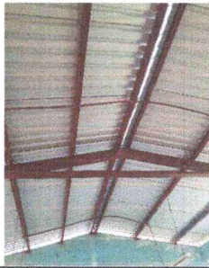
Foto 1: SUSTITUCIÓN DE TECHO
