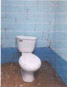
foto 7: SUSTITUCÓN DE SERVICIOS SANITARIOS
