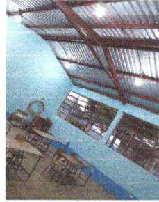
foto 8: SUSTITUCION E INSTALACION DEL SISTEMA ELECTRICO
