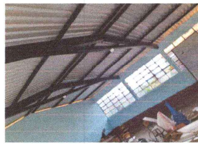
Foto 2: SUSTITUCIÓN DE LA ESTRUCTURA DEL TECHO
