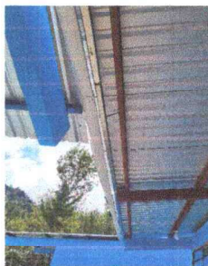
Foto 5: SUSTITUCIÓN DE CANALES Y BAJADAS DE AGUA PLUVIALES
