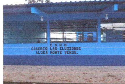
Foto 4: SUSTITUCIÓN, Y REPARACIÓN DE VENTANAS
