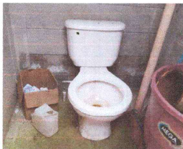
foto 7: SUSTITUCIÓN DE SERVICIOS SANITARIOS
