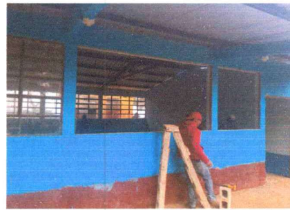
Foto 4: SUSTITUCIÓN, Y REPARACIÓN DE VENTANAS
