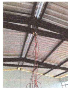
foto 8: SUSTITUCIÓN E INSTALACION DEL SISTEMA ELECTRICO
