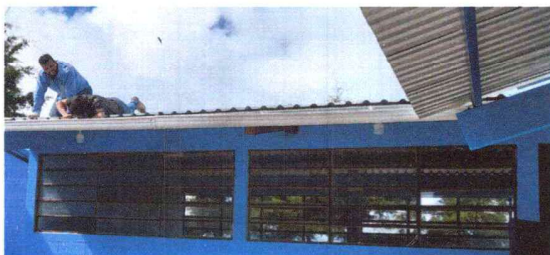
Foto 5: CANALES Y BAJADAS DE AGUA BLUVIAL
