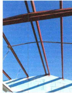
Foto 2: SUSTITUCIÓN DE LA ESTRUCTURA DEL TECHO
