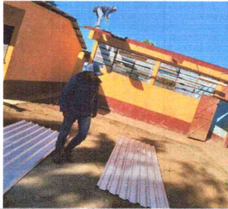
Foto 1: SUSTITUCIÓN DE TECHO
