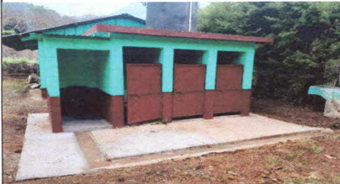
Foto3: MANTENIMIENTO A PUERTAS.
