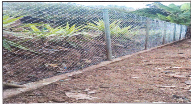
Foto4: SUSTITUCION DE CERCO O MURO PERIMETRAL.
