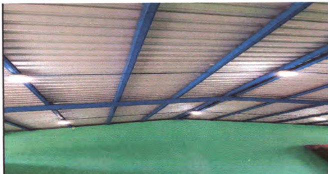
Foto: 5 REPARACION DE SISTEMA ELECTRICO.
