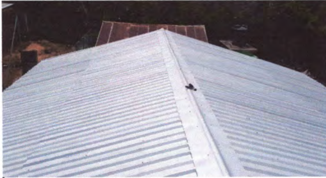
Foto1: CUBIERTA DE LAMINA FINALIZADA.
