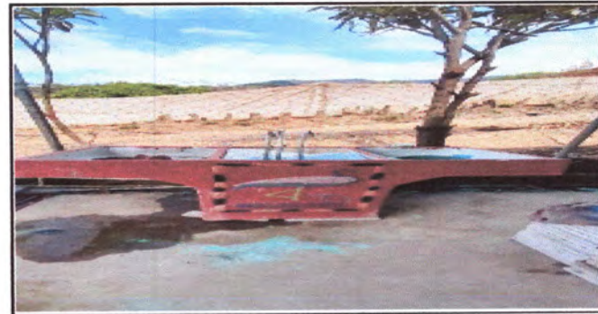
Foto: 6 CAMBIO DE DEPOSITO DE AGUA.
