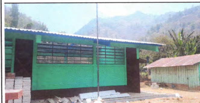
Foto: 5 PINTURA DE MUROS EN EXTERIOR
