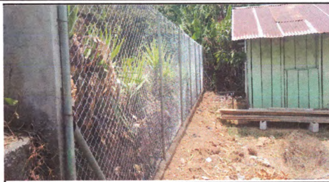
FOTO 2: SUSTITUCION DE DE CERCO O MURO PERIMETRAL.
