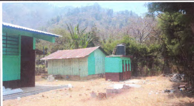
Foto1: MANTENIMIENTO SERVICIO DE SANITARIO Y DRENAJE
