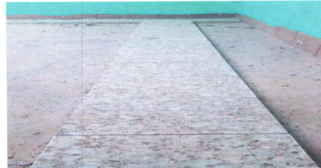
Foto: 6 COLOCACION DE PISO.
