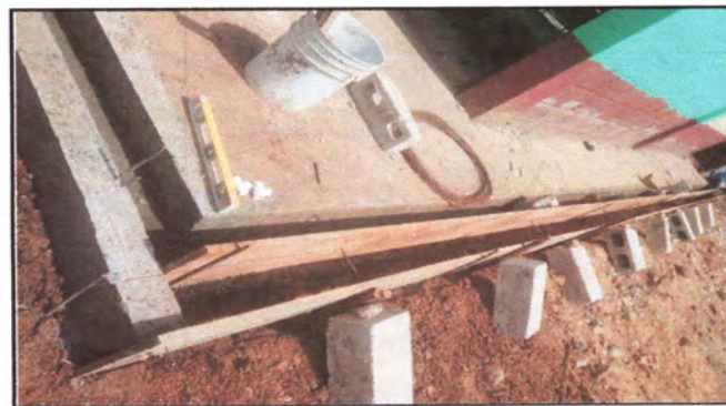
Foto4: REPARACION DE CUNETA DE CONCRETO
