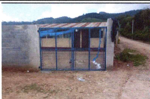
Foto1: Reparación del portón principal
