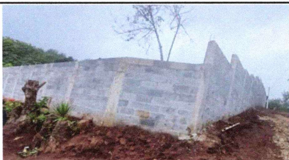
Foto 3: Reparacion del muro
