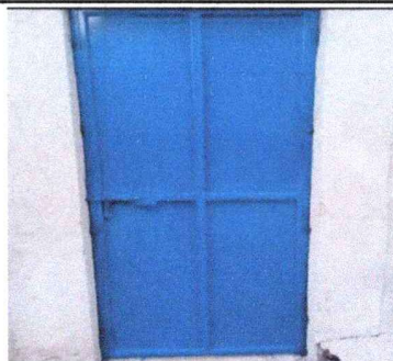
Foto 2: reparación de puerta del costado
