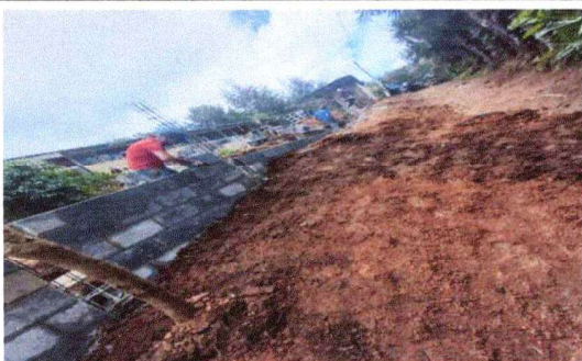
Foto 3: Reparacion del muro
