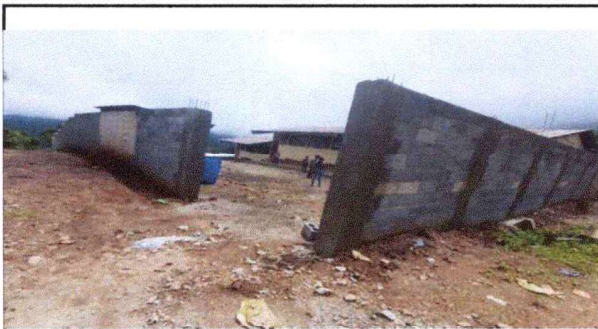
Foto 1: Reparación del portón principal
