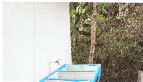
FOTO 8: REPARACIÓN DE RED DE DRENAJES Y RED DE AGUA POTABLE: Reparación total de red de tubería de agua potable. (renglón 14).
