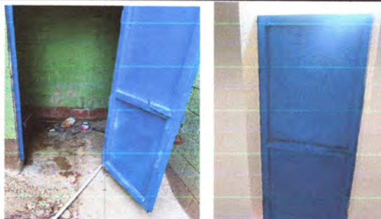
Foto4: Puertas: Sustitución de puerta de baño (renglón 4).
