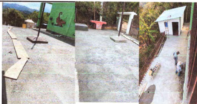
FOTO 9: LOSA DE PATIO : Sustitución de losa del patio. ( renglón 16)
