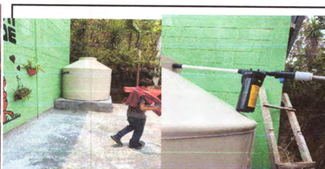
FOTO 10: REPARACIÓN Y MANTENIMIENTO DE CISTERNAS /DEPÓSITOS DE AGUA: Sustitución de cisterna de agua. ( renglón 18)
