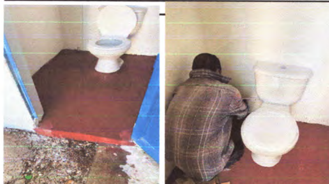
Foto 6: SERVICIOS SANITARIOS Y SUS ACCESORIOS: Sustitución del único sanitario. (renglón 10).
