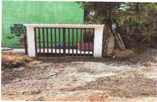
Foto 13: REPARACIÓN DE MUROS DE CONTENCIÓN : Reparación de muros de contención del portón . ( renglón 22)
