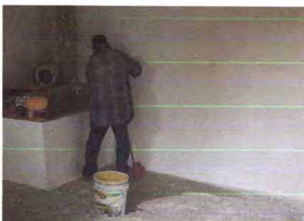
Foto3: IMPERMEABILIZACIÓN DE LOSA: En aula segundo nivel, baño, cocina y paco (renglón 3)
