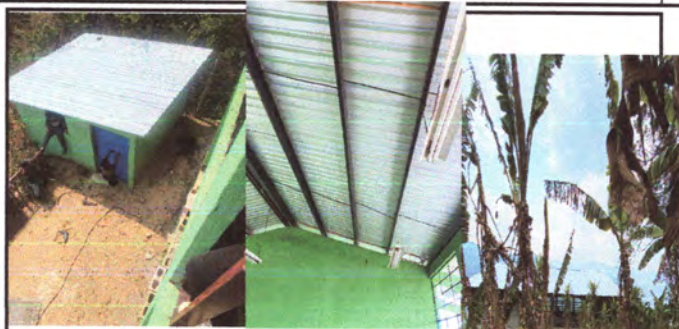
Foto1: SUSTITUCIÓN DE CUBIERTA DE LÁMINA: Sustitución en aula segundo nivel, cocina y baño, de la escuela ( renglón 1)
