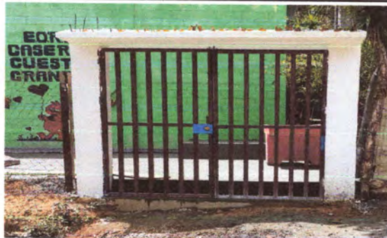
Foto 7: MATENIMIENTO A PORTONES: Colocación de chapa (renglón 12).
