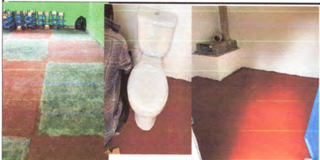
Foto 5: PISO: Sustitución en aula segundo nivel, cocina, paco y baño. (renglón 5).
