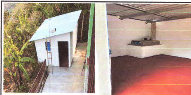
FOTO 12: REPARACIÓN DE REPELLO Y CERNIDO DE PAREDES: REPARACIÓN DE REPELLO EN COCINA, BAÑO ,PARTE EXTERNA AULA PRIMER NIVEL Y PACIO PRIMER NIVEL. (Renglón 21)
