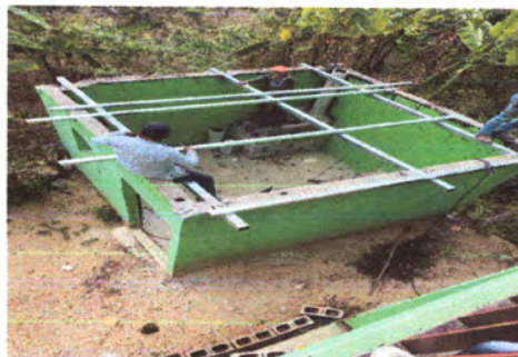
FOTO 2: ESTRUCTURA DE TECHO: Sstitución en cocina y baño. (renglón 2).
