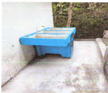
FOTO 11: REPARACIÓN O SUSTITUCIÓN DE ÁREA DE COCINA (ESTUFAS RURALES,PILAS,VENTANAS, PUERTAS Y CHIMENEAS): Sustitución de pila,puerta y ventana (renglón 18)
