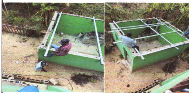
FOTO 2: ESTRUCTURA DE TECHO: Sstitución en cocina y baño. (renglón 2).
