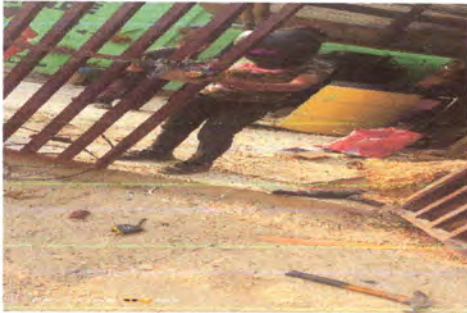
FOTO 7: MATENIMIENTO A PORTONES: Colocación de chapa (renglón 12).
