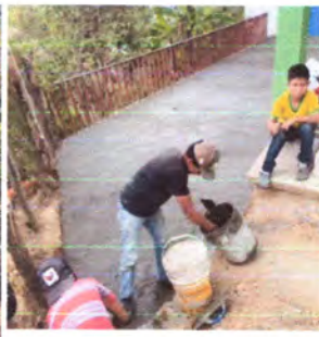
FOTO 9: LOSA DE PATIO : Sustitución de losa del patio. ( renglón 16)
