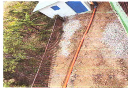
FOTO 8: REPARACIÓN DE RED DE DRENAJES Y RED DE AGUA POTABLE: Reparación total de red de tubería de agua potable. (renglón 14).
