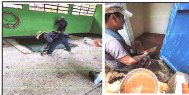
Foto 5: PISO: Sustitución en aula segundo nivel, cocina, pácio y baño. (renglón 5).
