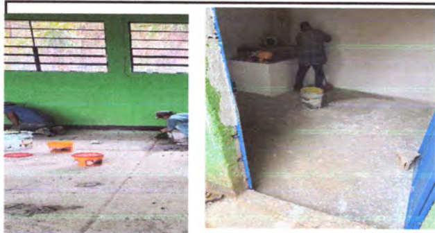
Foto3: IMPERMEABILIZACIÓN DE LOSA: En aula segundo nivel, baño, cocina y pácio (renglón 3)
