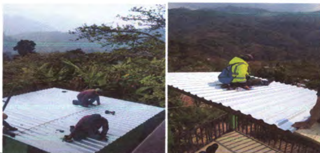
Foto1: SUSTITUCIÓN DE CUBIERTA DE LÁMINA:Sustitución en aula segundo nivel, cocina y baño, de la escuela ( renglón 1)
