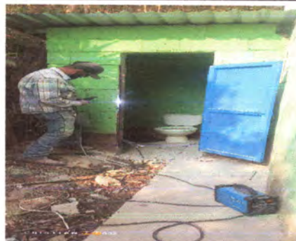
Foto4: Puertas: Sustitución de puerta de baño (renglón 4).
