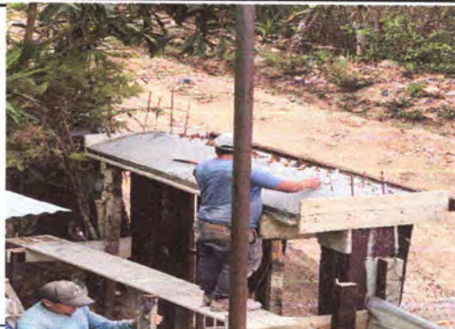
Foto 13: REPARACIÓN DE MUROS DE CONTENCIÓN : Reparación de muros de contención del portón . ( renglón 22)
