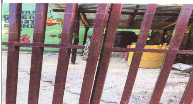
Foto 7: MATENIMIENTO A PORTONES: Colocación de chapa (renglón 12).
