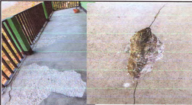
Foto3: IMPERMEABILIZACIÓN DE LOSA: En aula segundo nivel, baño, cocina y paco ( renglón 3)
