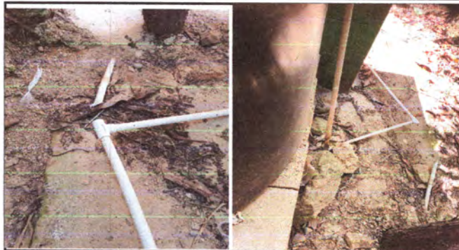
FOTO 8: REPARACIÓN DE RED DE DRENAJES Y RED DE AGUA POTABLE: Reparación total de red de tubería de agua potable. (renglón 14).
