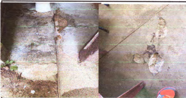
Foto 5: PISO: Sustitución en aula segundo nivel, cocina, paco y baño. (renglón 5).
