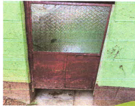
Foto4: Puertas: Sustitución de puerta de baño (renglón 4).
