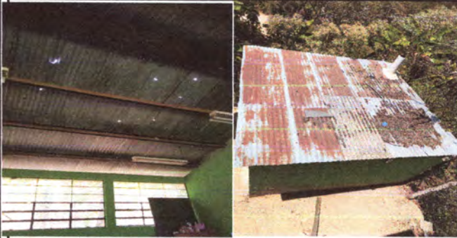
Foto1: SUSTITUCIÓN DE CUBIERTA DE LÁMINA: Sustitución en aula segundo nivel, cocina y baño, de la escuela ( renglón 1)
