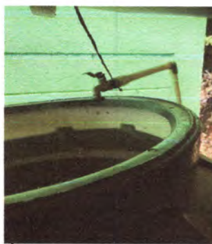
FOTO 10: REPARACIÓN Y MANTENIMIENTO DE CISTERNAS /DEPÓSITOS DE AGUA: Sustitución de cisterna de agua. ( renglón 18)
