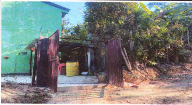
Foto 13: REPARACIÓN DE MUROS DE CONTENCIÓN : Reparación de muros de contención del portón . ( renglón 22)
