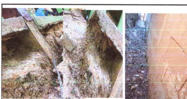
FOTO 12: REPARACIÓN DE REPELLO Y CERNIDO DE PAREDES: REPARACIÓN DE REPELLO EN COCINA, BAÑO ,PARTE EXTERNA AULA PRIMER NIVEL Y PACIO PRIMER NIVEL. (Renglón 21)
