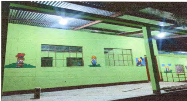
Foto11: PINTURA DE PAREDES
