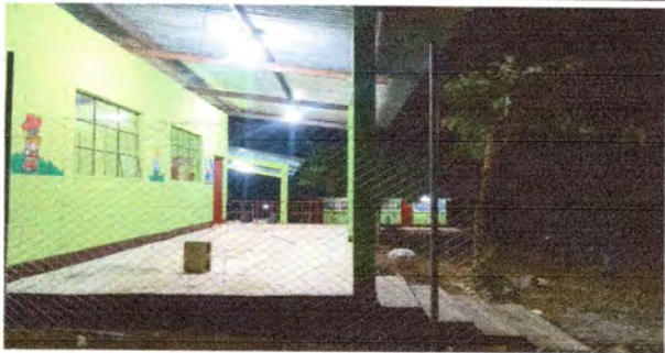
Foto7: REPARACION DEL SITEMA ELECTRICO EN EL ESTABLECIMIENTO
