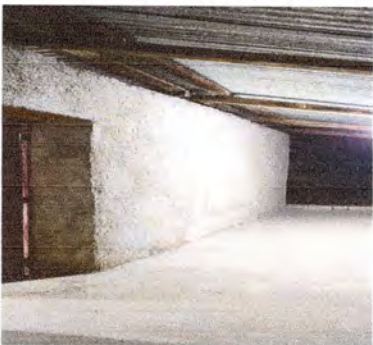
Foto9: REPARACION DE REPELLO DE PAREDES.
