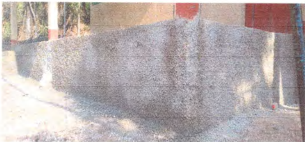
Foto10: REPARACION DE MURO DE CONTENCION 13 M3
