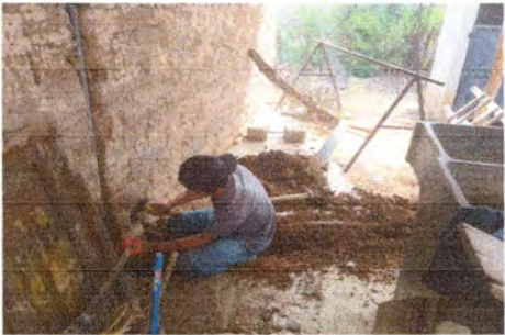
Foto: 5 REPARACION DE DRENAJES Y RED DE AGUA POTABLE
