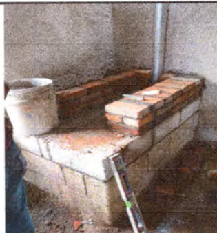
FOTO 8: REPARACION DE AREA DE COCINA
