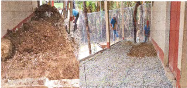
Foto4: PISO( REPARACION DE TORTA LISA EN CORREDOR DE AULA Y COCINA)
