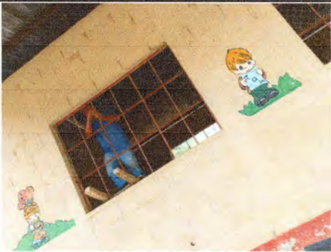
Foto3: REPARACION DE VENTANAS
