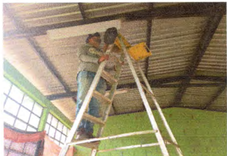
Foto7: REPARACION DEL SISTEMA ELÉCTRICO EN EL ESTABLECIMIENTO
