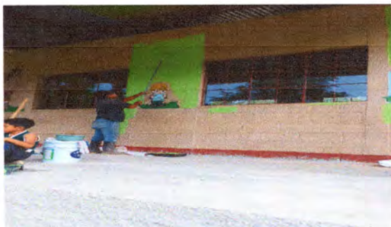
Foto11: PINTURA DE PAREDES
