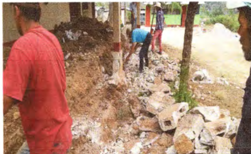
Foto10: REPARACION DE MURO DE CONTENCIÓN 13 M3
