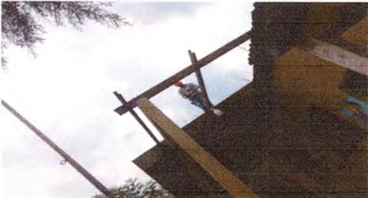
Foto1: REPARACION CUBIERTA DE LAMINA
