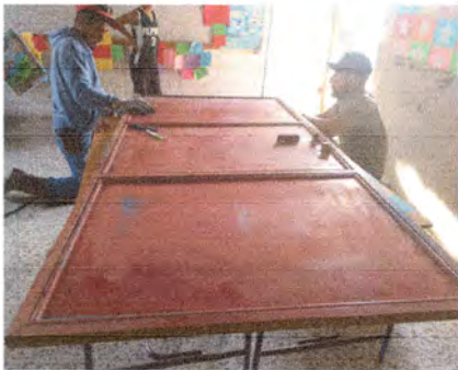
FOTO 2: REPARACION DE PUERTAS
