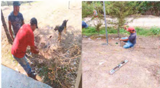
Foto: 6 REPARACION Y SUSTITUCION DE CERCO 214 ML
