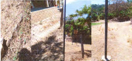
Foto: 6 REPARACION Y SUSTITUCION DE CERCO 214 ML
