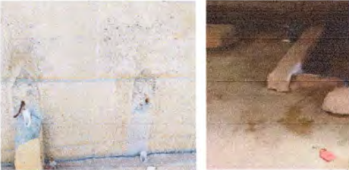
Foto: 5 REPARACION DE DRENAJES Y RED DE AGUA POTABLE
