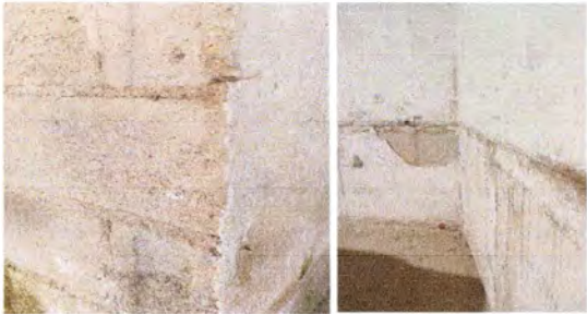
Foto9: REPARACION DE REPELLO DE PAREDES.
