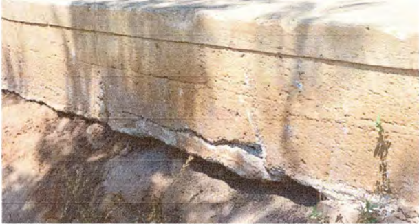
Foto10: REPARACION DE MURO DE CONTENCIÓN 13 M3
