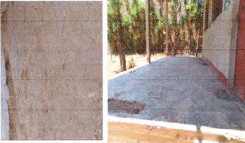
Foto4: PISO( REPARACION DE TORTA LISA EN CORREDOR DE AULA Y COCINA)
