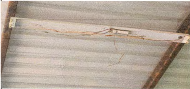
Foto7: REPARACION DEL SITEMA ELECTRICO EN EL ESTABLECIMIENTO
