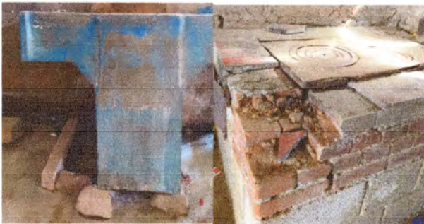
FOTO 8: REPARACION DE AREA DE COCINA
