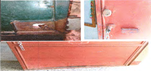
FOTO 2: REPARACION DE PUERTAS
