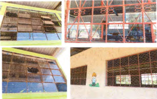
Foto3: REPARACION DE VENTANAS
