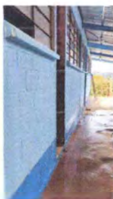
Foto 3: pintura en interior y exterior
