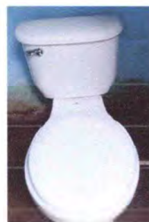
Foto 4: servicios sanitarios y sus accesorios
