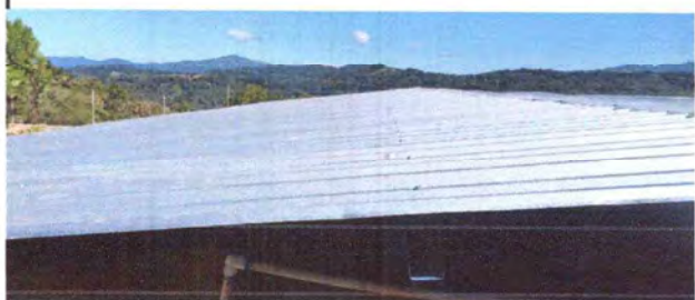
Foto 1: Cubierta de lámina (sustitución de lámina troquelada por mal estado)
