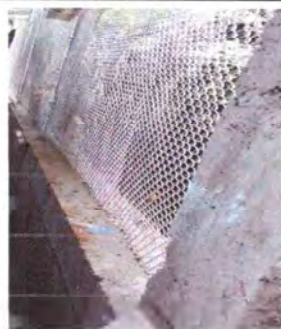
Foto 5: cerco o muro perimetral (sustitución de malla, blocks quebrados y tubos galvanizados)
