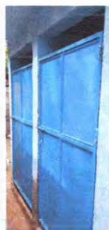
Foto 2: Puertas (sustitución de puertas)
