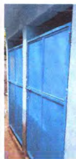
Foto 2: Puertas (sustitución de puertas)
