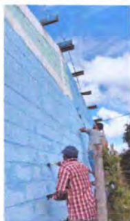
Foto 3: pintura en interior y exterior
