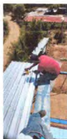
Foto1: Cubierta de lámina (sustitución de lamina troquelada por mal estado)
