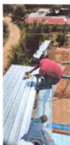
Foto1: Cubierta de lámina (sustitucion de lamina troquelada por mal estado)
