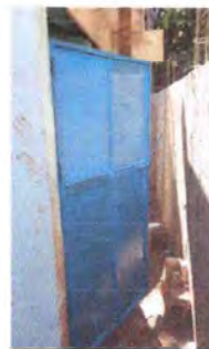
Foto 2: Puertas (sustitución de puertas)
