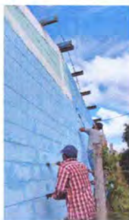
Foto 3: pintura en interior y exterior
