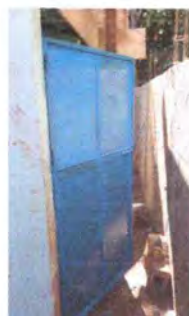
Foto 2: Puertas (sustitución de puertas)
