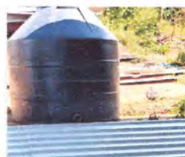
Foto 6: Reparación de cisternas/ depósitos de agua (tipo rototoplas)
