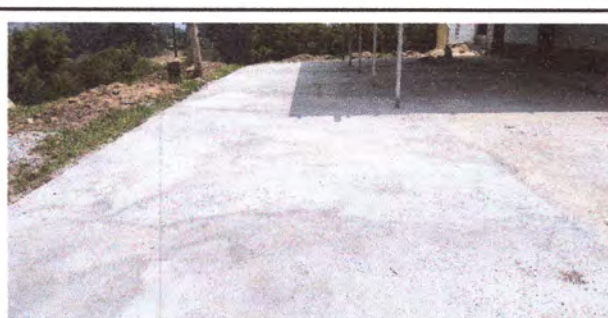
Foto 4: LOSA DE PATIO
