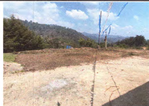
Foto 4: LOSA DE PATIO
