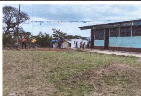
Foto 4: LOSA DE PATIO
