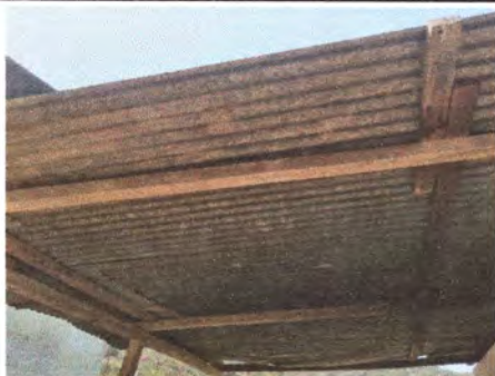
Foto 3: TECHO DE PATIO
