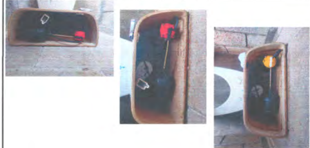
FOTO 2: REPARACION DE BAÑOS
