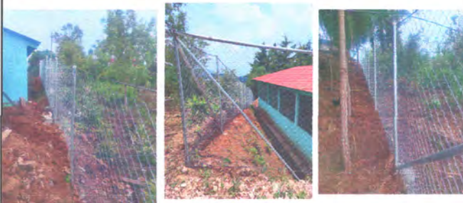
Foto3: SUSTITUCION DE CERCO PERIMETRAL
