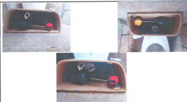
FOTO 2: REPARACION DE BAÑOS
