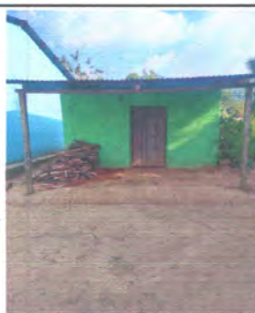
FOTO 4: SUSTITUCION DE TECHO
