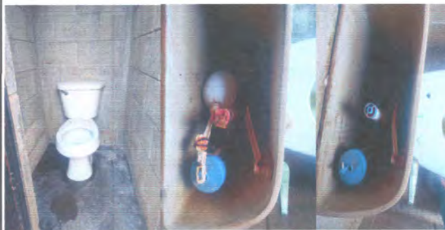
FOTO 2: REPARACION DE BAÑOS
