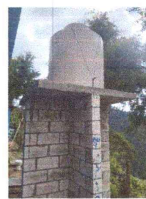
Foto.6 SUSTITUCIÓN DE DEPOSITO DE AGUA (ROTOPLAS) Y SU BASE
