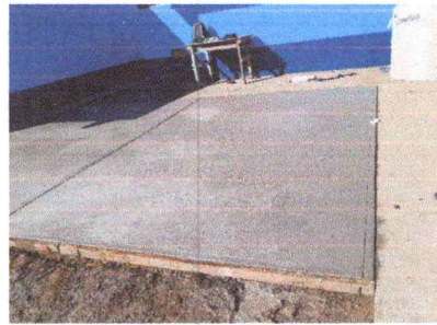
Foto 4: SUSTITUCIÓN Y REPARACIÓN DE LOSA DE PATIO
