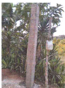
Foto 5: SUSTITUCIÓN E INSTALACIÓN DE COMETIDA CON BASE
