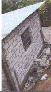
Foto1: SUSTITUCIÓN PARED DE COCINA
