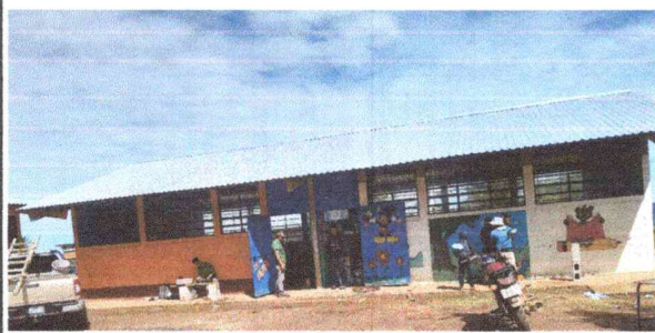
Foto1: SUSTITUCIÓN DE TECHO
