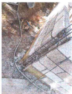
FOTO NO. 7 REPARACION PARED DE COCINA
