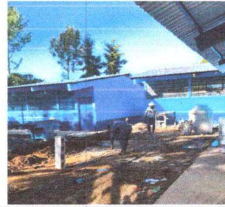
Foto 4: REPARACIÓN LOSA DE PATIO
