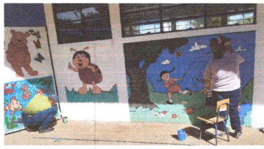
Foto 2: PINTURA INTERIORES Y EXTERIORES
