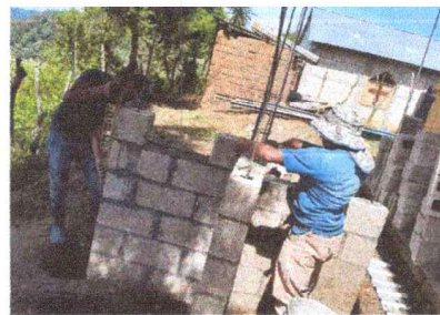
Foto 6: SUSTITUCIÓN DE DEPOSITO DE AGUA (TIPO ROTOPLAS) CON SU BASE
