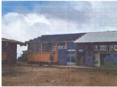
Foto 1: SUSTITUCIÓN DE TECHO
