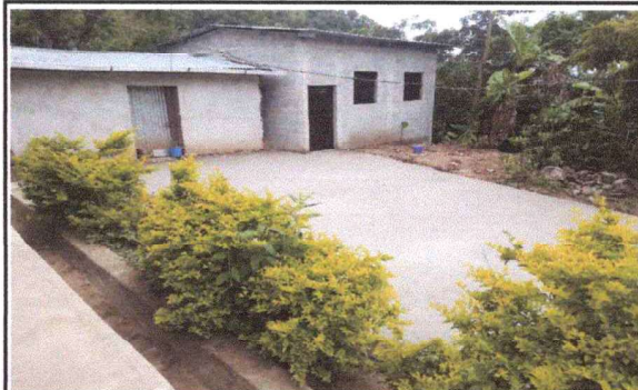
Foto 4: losa de patio, sustutucion de lamina
