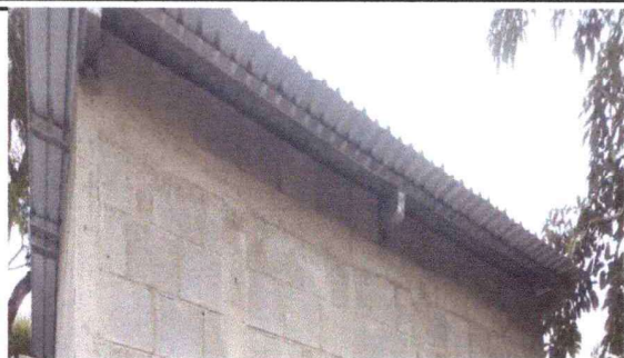
Foto1: trabajando en la sustitucion de lamina
