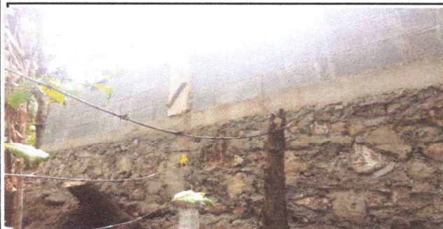
Foto 5: sustitucion de muro de block
