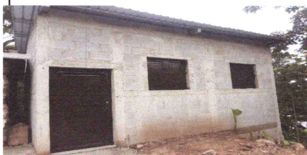
Foto 2: Ttrabajando en la sustitucion de puertas y ventanas,
