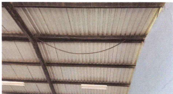
Foto 3: sustitucion de lamina
